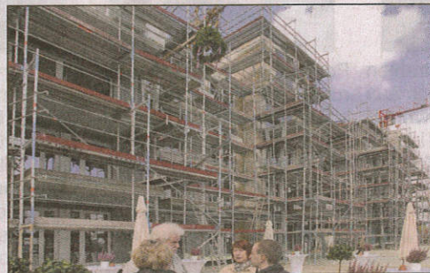
Gestern wurde Richtfest für zwei weitere Stadtvillen am Holtenauer Fördeufer gefeiert. Foto Rebe r n
